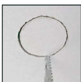
średnice otworów montażowych: DLW-R075/S075: ø55 DLW-R125/S125: ø105 DLW-R185/S185: ø165 DLW-R215/S215: ø195
