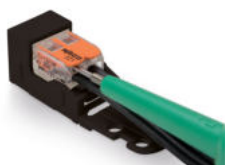
Zkoušení svorky namontované v adaptéru pomocí zkušebních otvorů.
