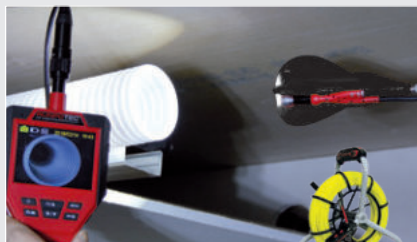
Kontrola a servis vzduchotechniky
