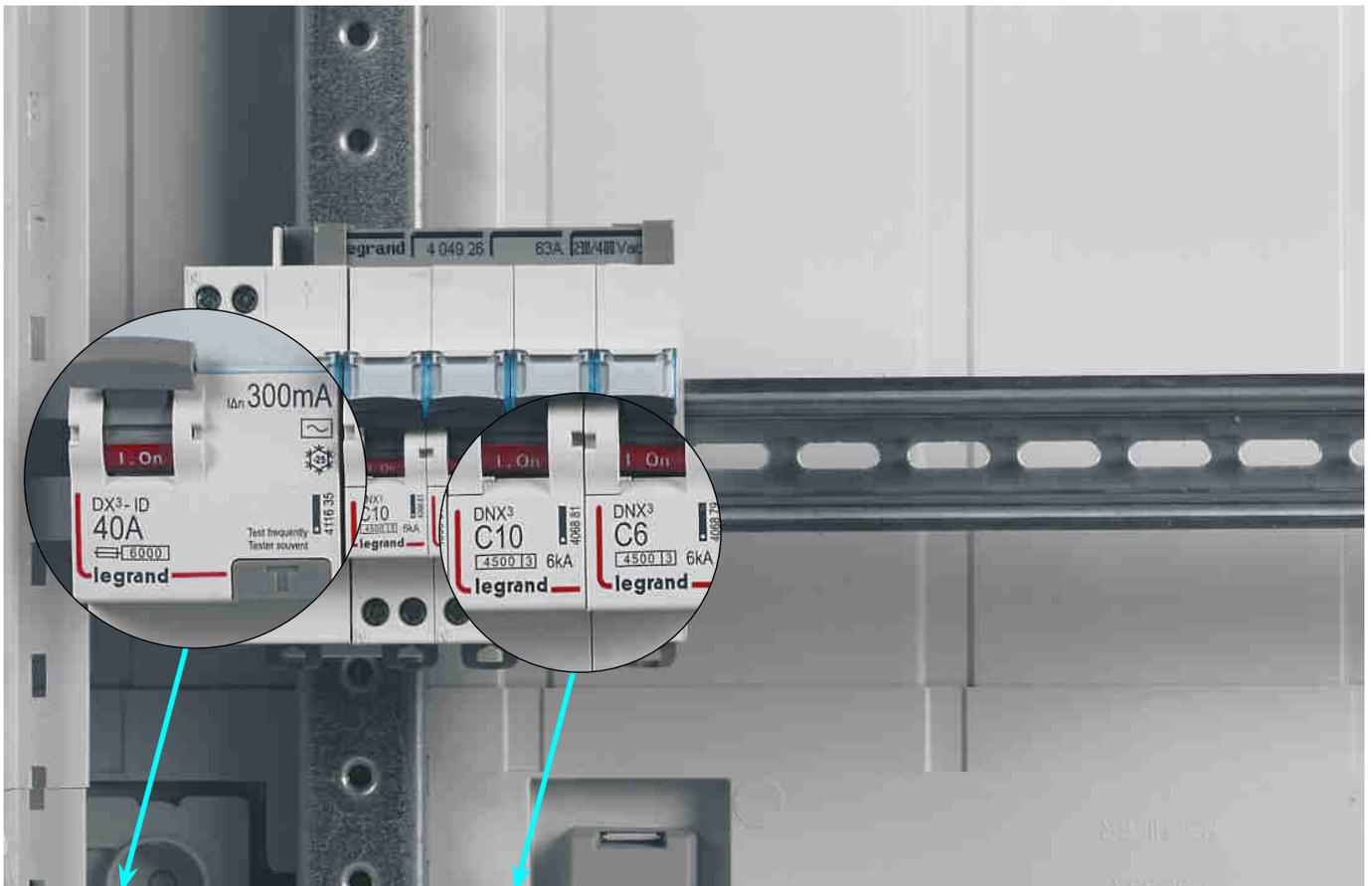
L'interrupteur différentiel 40 A de niveau 2 est protégé thermiquement par le contrôle de la somme des calibres des protections niveau 3.
