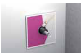
4. Naneste Tangit FP 800 Protipožární plášť na pěnu s přesahem 3 cm na stěnu
