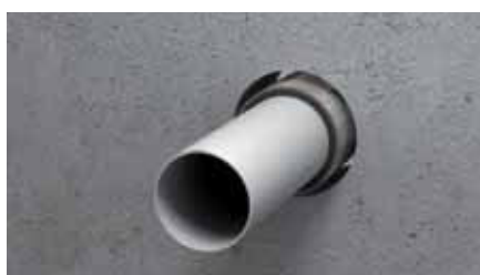
4. Zasuňte manžetu do otvoru a vycentrujte ji.
