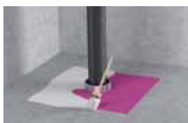
4. Naneste Tangit FP 800 Protipožární plášť na pěnu s přesahem 3 cm na podlahu / strop
